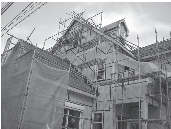
工事中のN邸
