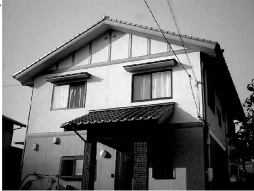
完成したS部
